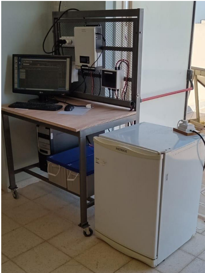
Figura 1. Vista de los equipos: pc, baterías, protecciones, controlador MPPT y heladera
